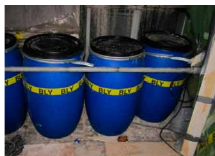
Opbevaring af blyholdigt facade-malingsaffald i aflukkede tønder med spændelåg.
