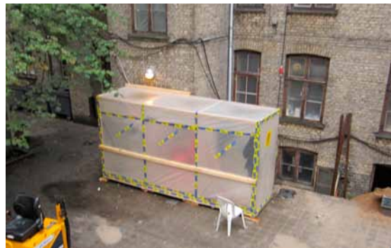
3-kammer-sluse med adskillelse af ren og beskidt zone
